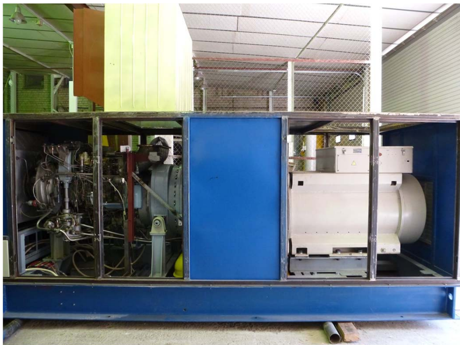
Общий вид ГТЭС-800 в контейнере
