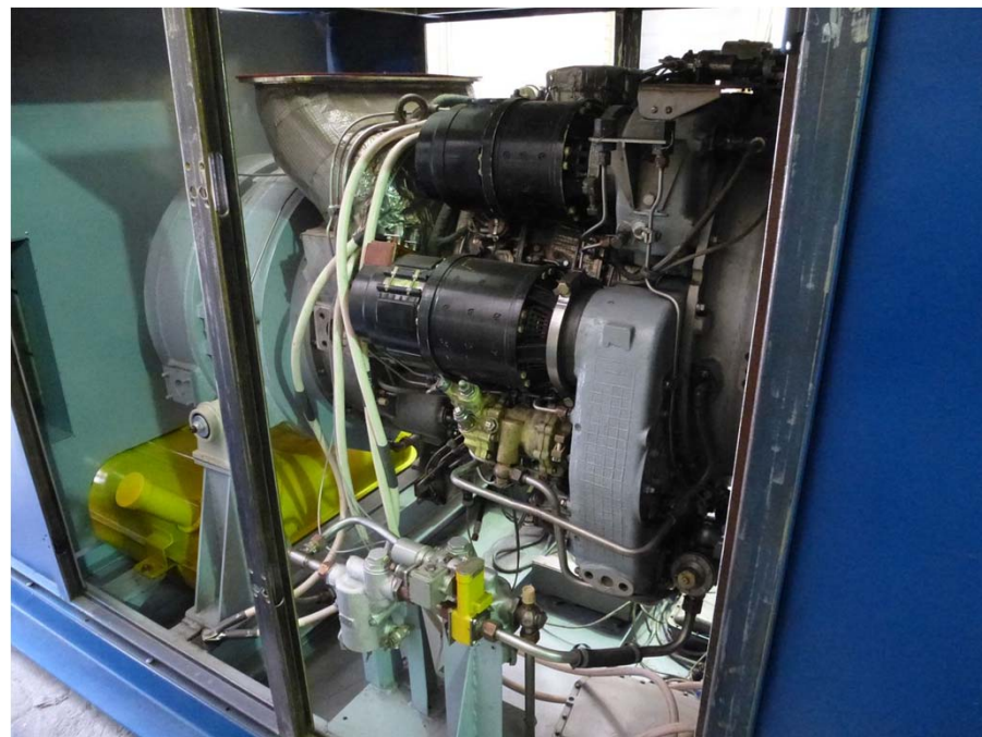
ГТД и редуктор внутри контейнера
